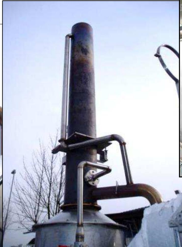
Abgasrohr mit Sonde
